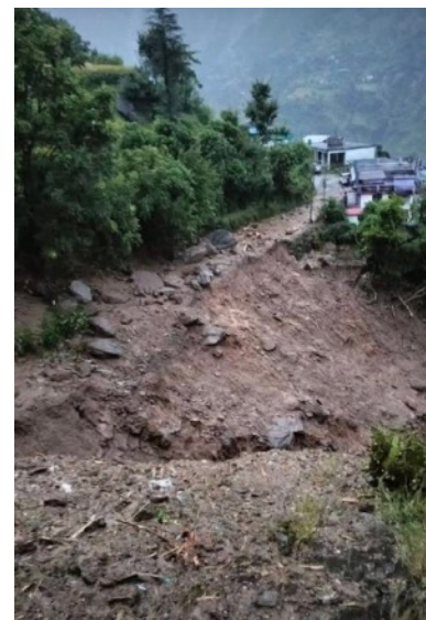
Vägen till Bareth spolades bort i de kraftiga skyfallen.
